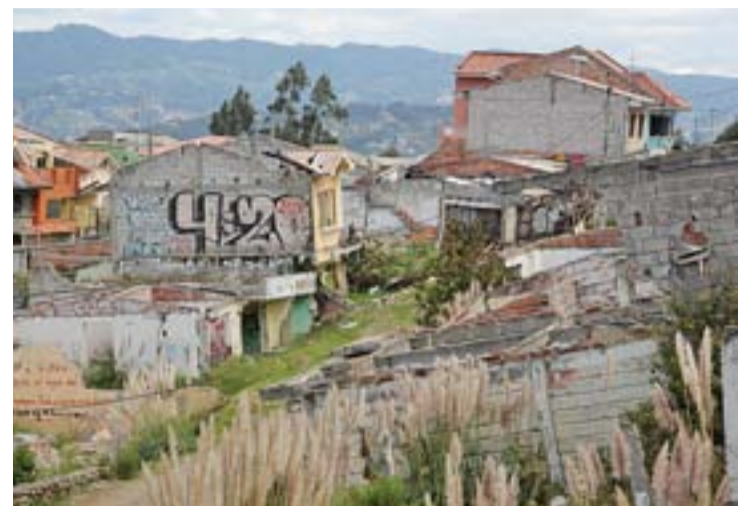
En la zona de un deslizamiento en los Triguales Altos se tiene prevista la construcción de la obra. — Diego Cáceres | EL TIEMPO
