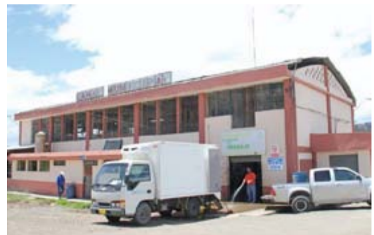
En abril iniciará la construcción del nuevo camal y, para el próximo año, se prevé que entre en funcionamiento. — Cortesía
